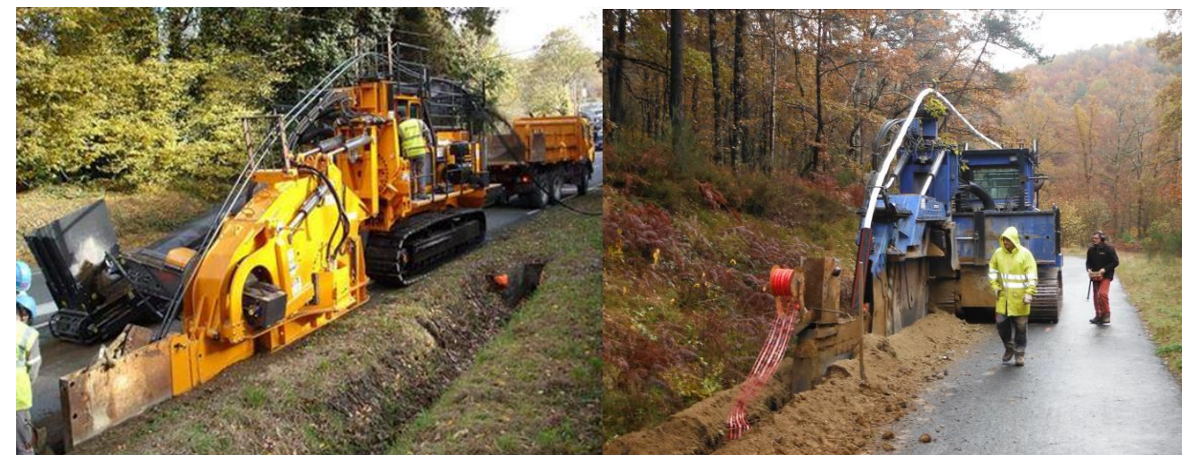
Figure 2: Trancheuse et exemple de pose de câble à la trancheuse
